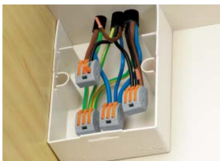
Подключение предварительно смонтированных компонентов.
