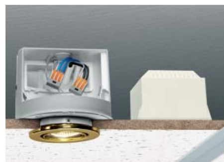
Подключение низковольтных светильников
