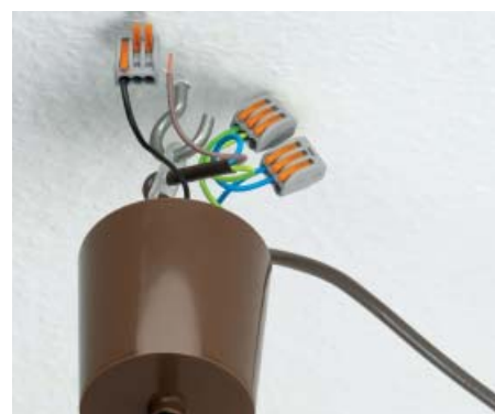
Петлевое подключение осветительного прибора гибкими проводниками.
