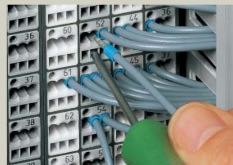
Подсоединение проводов с наконечниками
