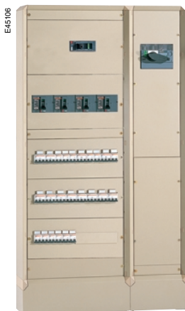
E45106 Распределительный щит Prisma с выключателями-разъединителями Interpact
