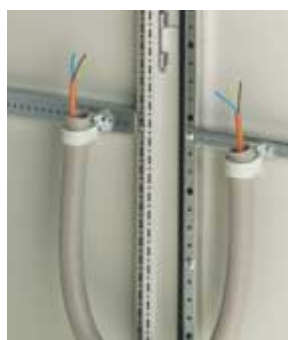
Кабельные каналы и зажимы для надежной прокладки от двери к корпусу. Арт. № см. стр. 953.
